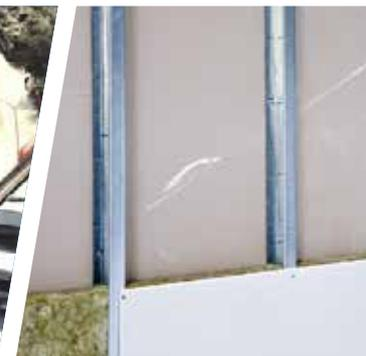
» Ossatures métalliques pour plaques de plâtre
